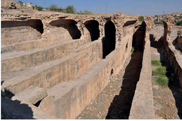
▲ Mardin'e bağlı Oğuz köyündeki Dara Antik Kenti'nde bulunan ve yağmur sularını hem açık hem kapalı alanda depolamak amacıyla yapılan su sarnıcı
