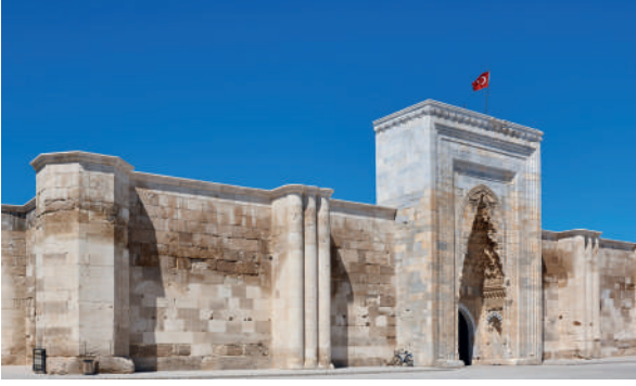
Aksaray-Konya arasında bulunan Sultanhanı Kervansarayı, Aksaray / Türkiye
