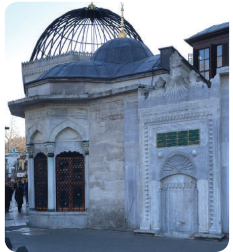
Üsküdar Yeni Valide Camii sebil ve çeşmesi, İSTANBUL.
