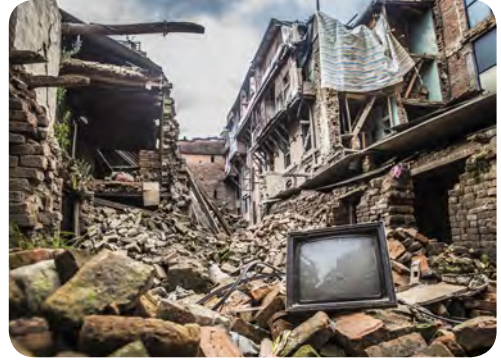
Görsel 6.14. Depremin oluşturduğu hasar
